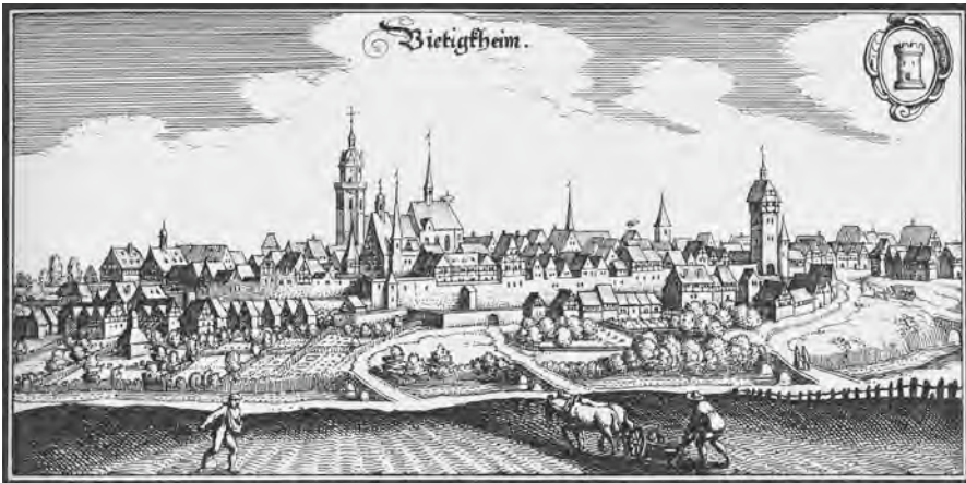
Ansicht der Stadt Bietigheim in Matthäus Merians »Topographia Sueviae« von 1643.
