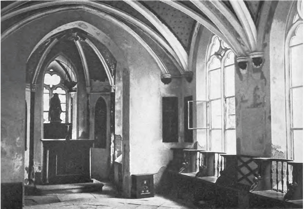
Der Innenraum der Kapelle in einer Aufnahme von Kayser-Thouret 1943.
