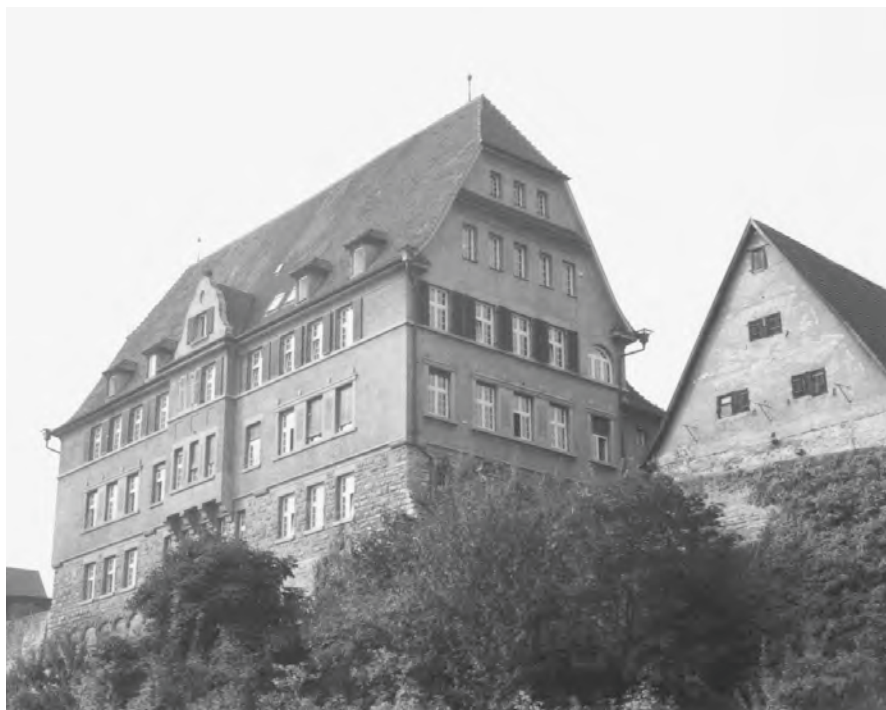
Das 1908 erbaute Oberamtsgebäude.
