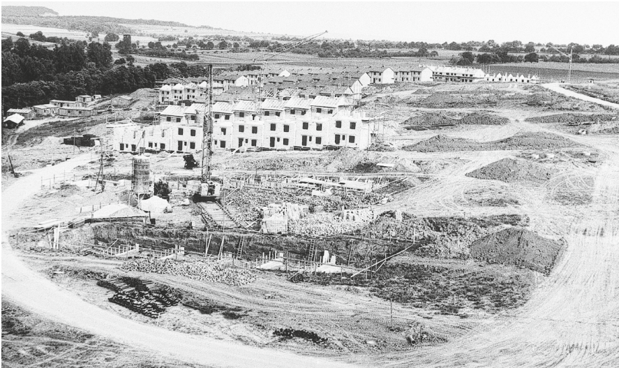
Die ersten Häuserzeilen im Robbau, 1958.
