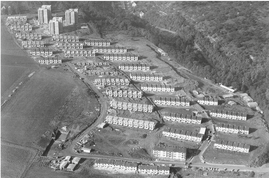
Stand der Bauarbeiten am 24. Oktober 1958.
