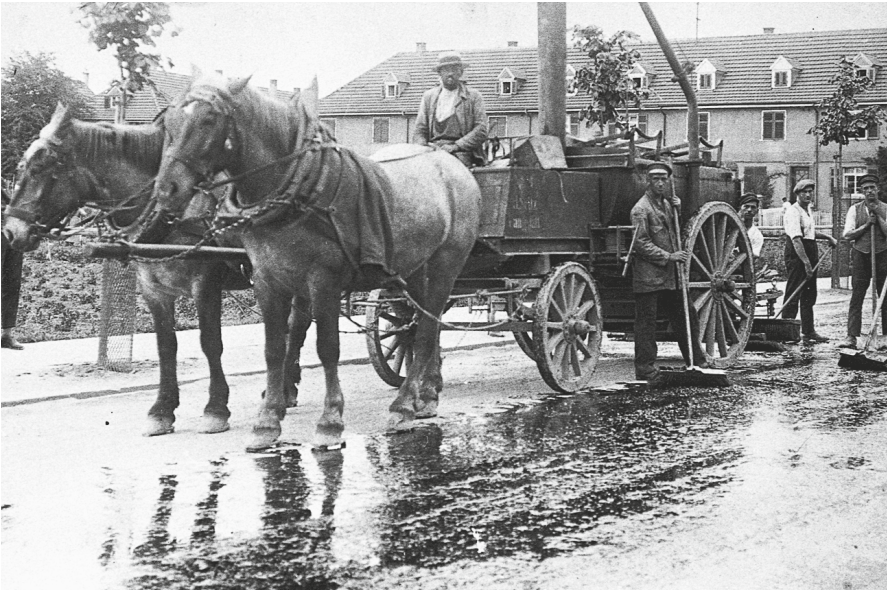
Straßenasphaltierung in Kornwestheim. Ab Mitte der 20er Jahre erhielten die meisten Straßen im Oberamtsbezirk einen Teerbelag.
