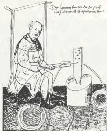
Abb. 44: Drahtzieher (Schockenzieher) bei der Arbeit mit dem Zieheisen. Zum besseren Einsatz seines Körpergewichtes sitzt er auf einem an der Decke befestigten Schaukelbrett, einer Schocke. Aus dem Hausbuch der Nürnberger Zwölfbrüderstiftung (15. Jh.).
