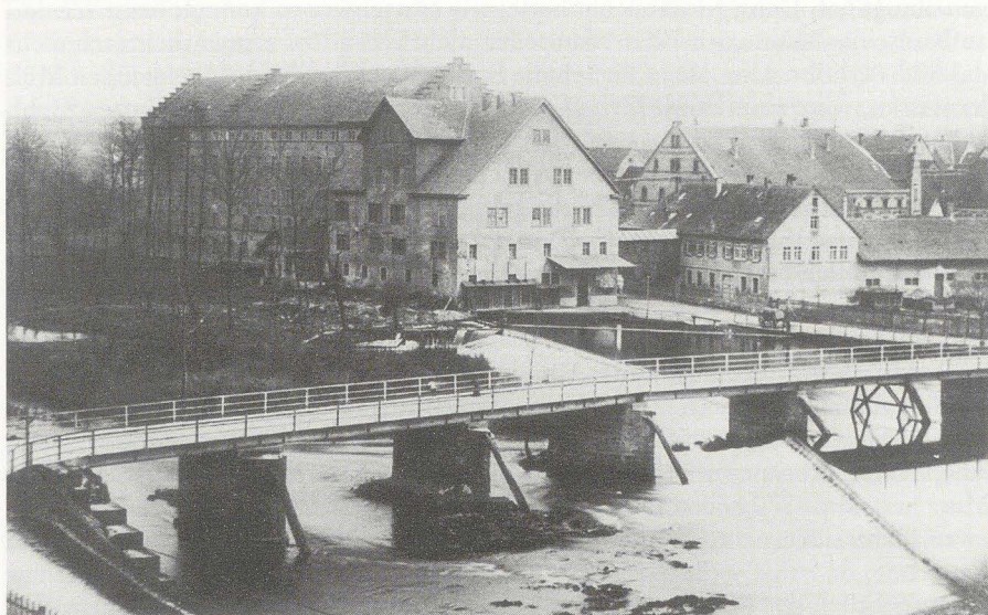
Die Rommel-Mühle in Bissingen, um 1900. In der Bildmitte die 1803 von Adam Klotzbücher erbaute Mühle, dahinter die 1879/80 von Karl Rommel erbaute Kunstmühle. Beide Mühlen brannten 1903 bzw. 1904 ab und wurden durch das heute noch vorhandene siebenstöckige Mühlengebäude ersetzt.
