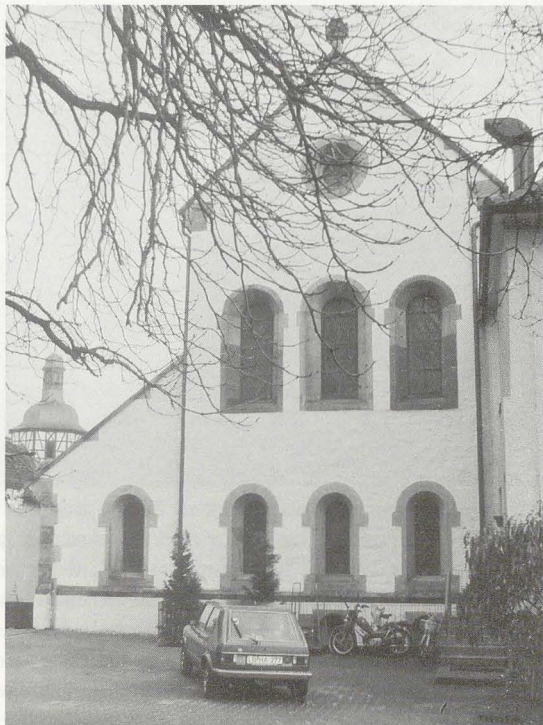
Die 1888/91 veränderte Westfassade. Der Dachverlauf zeigt die Form einer Basilika, wemngleich das südliche Seitenschiff durch das Stiftsgebäude verdeckt ist.
