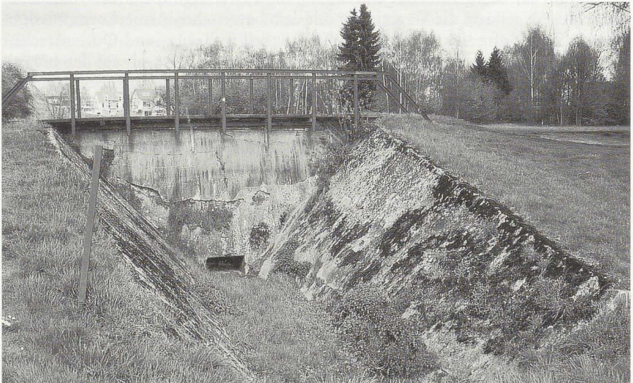
Staumauer des Sammelweihers Nr. 2 am Frauenriedbach, erbaut 1898/1903 (Aufnahme 1998).
