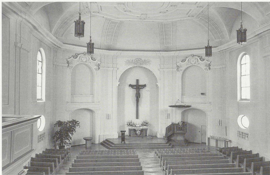
Innenansicht nach dem Umbau von 1889.
