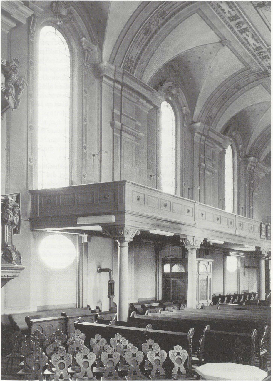
Nordseite des Kirchenschiffs mit der nach vorne gezogenen Empore, den nach oben verlängerten Fenstern und den in die Decke eingeschnittenen Kappen.
