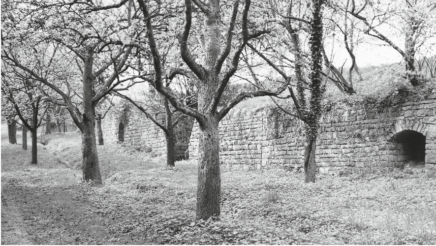
Von der Frauenkirche oberhalb von Unterriexingen nach Südwesten in Richtung Muckenschupf verlaufender Panzergraben, verstärkt durch eine Natursteinmauer (Aufnahme von 1981).
