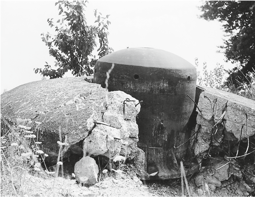
Der im Bataillonsabschnitt Rotenackerwald gelegene Artillerie-Beobachtungsstand URo 26 nach seiner Sprengung 1947/48. Die Beobachtungs-Panzerkuppel ist noch deutlich erkennbar.
