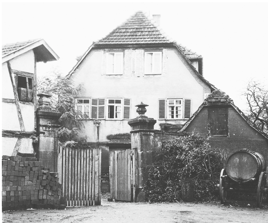
Das von Gabriel Dreifuß 1802 renovierte ehemalige Pfarrhaus.
