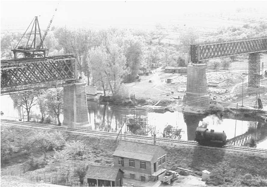
Wiederaufbau des Neckarviadukts.
