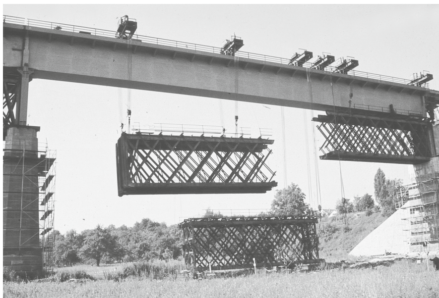
Demontage des alten Neckarviadukts.
