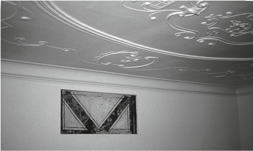
Markgröningen, Marktplatz 2: Unter Putz entdecktes Scheinfachwerk, Wanddekoration reicher Bürger aus der Mitte des 16. Jahrhunderts.
