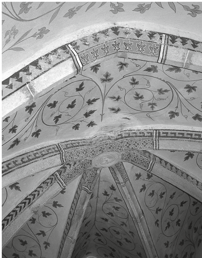
Historisches Chorgewölbe mit Pflanzenornamenten, die ein Element des Historismus der Kirchensanierung 1874/75 sind. Die Malereien wurden 2003 gereinigt und die Wasserschäden beseitigt.
