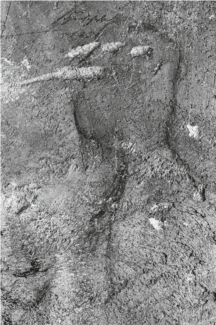
Abb. 8: »Figur mit Krawatte«, Rötzel, um 1725-1731, Festinbau, Dachboden, in einer Fensterlaibung.
