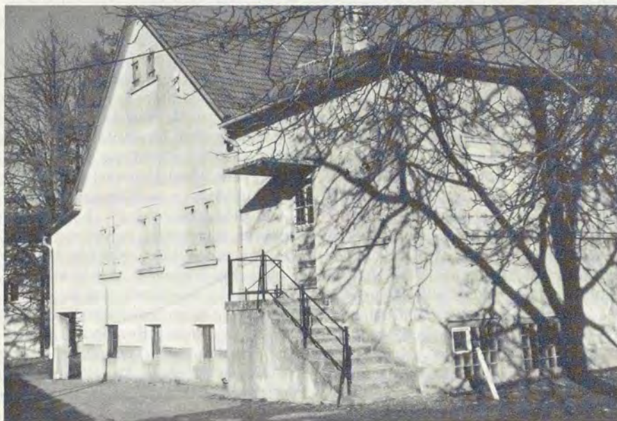
Die Marbacher Spielplatzhalle, Westseite.
