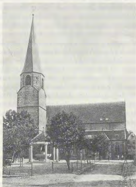
Stadtkirche Bönningheim mit Denkmal zum Bau der Wasserleitung von 1908.
