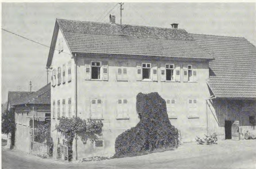
Ehemalige Jüdische Schule und Synagoge in Hochberg
