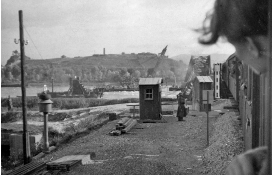
Abb. 5: Breisacher Rheinbrücke nach dem 25. Juli 1940, aus dem Zug fotografiert von der elsässischen Seite aus vor der Behelfsbrücke. Im Hintergrund der Eckartsberg, links von der wiederaufgebauten Eisenbahnbrücke sind die Trümmer der alten Brücke im Rhein zu sehen. Außerdem erkennt man zwei Wachhäuschen und zwei Soldaten. Die Aufnahme müsste perspektivisch von einem Zuginsassen gemacht worden sein. Vorlage: Stadtarchiv Breisach am Rhein.
