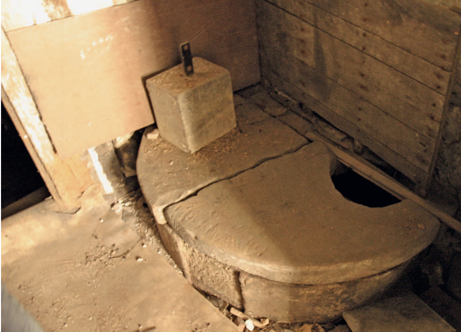
Abb. 4: Obertägiger Brunnenkranz noch in situ erhalten im Nebengebäude am Hinterhof von Glaserstraße 8. Aufnahme: Valerie Schoenenberg.
