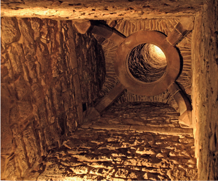
Abb. 3: Blick in das Gewölbe des Badeschachtes. Die Kreuzrippen und der daran ansetzende Steinkranz überführen den unteren quadratischen Grundriss in einen runden oberen Schacht: Aufnahme: Valerie Schoenenberg.
