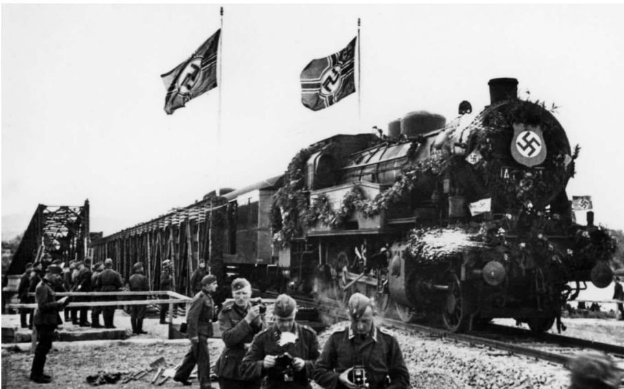
Abb. 4: Der erste Zug über die Breisacher Rheinbrücke nach Colmar am 25. Juli 1940 mit eingleisiger Schienenführung. Aufnahme: Foto Mühlbauer. Vorlage: Stadtarchiv Breisach am Rhein.
