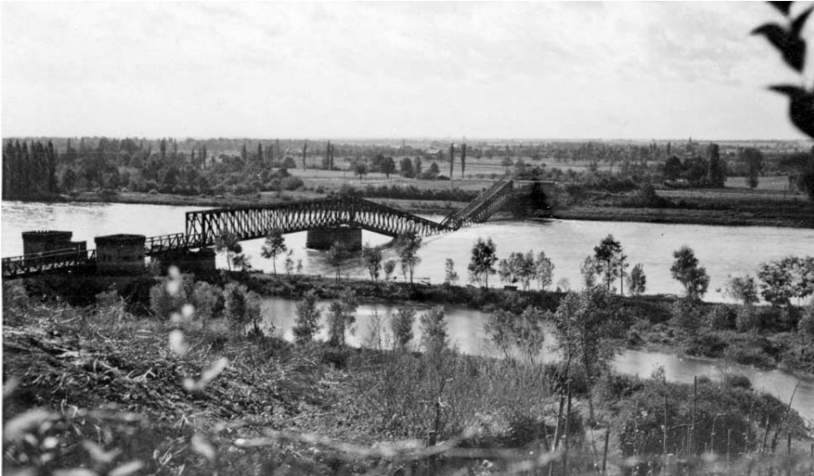
Abb. 1: Die am 12. Oktober 1939 von französischen Pionieren gesprengte Eisenbahnbrücke Breisach. Aufnahme von Rudolf Hanselmann, Breisach. Vorlage: Stadtarchiv Breisach am Rhein.
