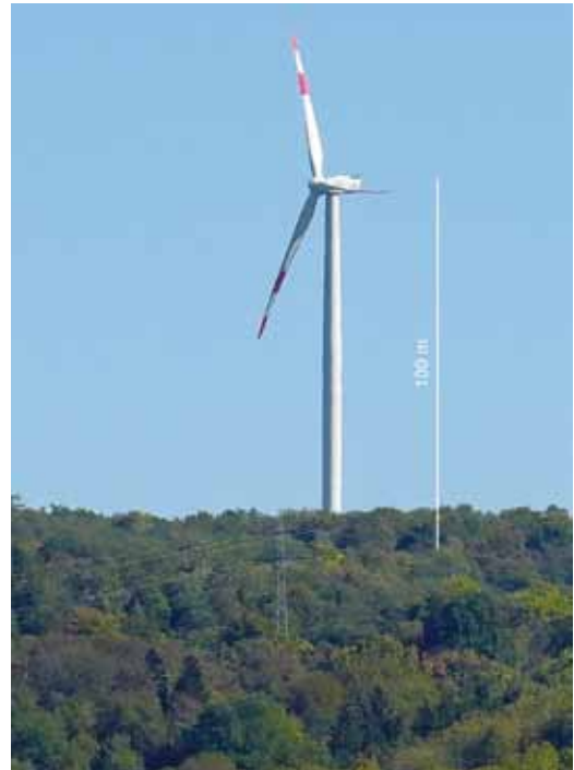
Abbildung 1. Die Windenergieanlage (WEA) auf dem Gelände des Fraunhofer-Instituts für Chemische Technologie in Pfnitztal (ICT) vom Silzberg, dem Standort des manuellen Lichtfangs (mLF) aus gesehen. Sie gehört mit 100 m Nabenhöhe und 82 m Rotordurchmesser zur dominierenden dreiblättrigen Bauform. Mit ihren 2 Megawatt (MW) Leistung rangiert sie im unteren Leistungsbereich heute gängiger Onshore-Anlagen. Sie wurde für das ICT errichtet, um die Zwischenspeicherung der mit der WEA erzeugten elektrischen Energie in einer Redox-Flow-Batterie mit einem Endausbau von 20 MWh Kapazität zu testen. – Foto: R. MÖRTER.
