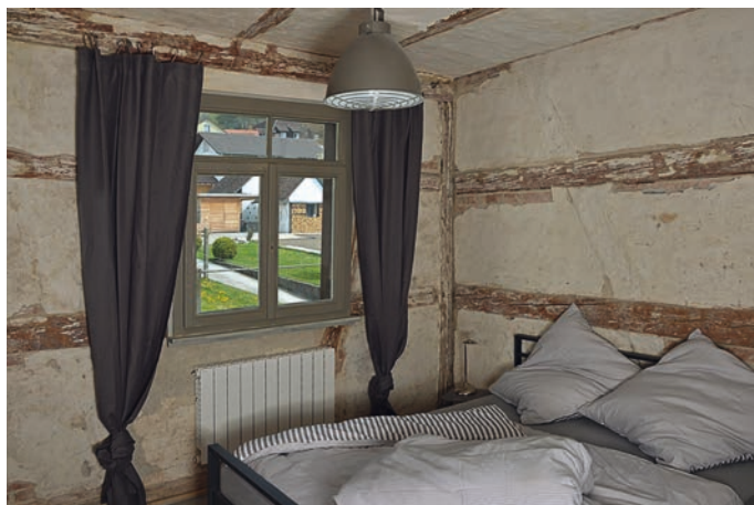
Schlafzimmer in der westlichen Ferienwohnung im ersten Obergeschoss. Die bauzeitlichen Putze und Fassungen der Wände sind großflächig erhalten und wurden restauratorisch gesichert. (Foto: Corinna Wagner-Sorg)
