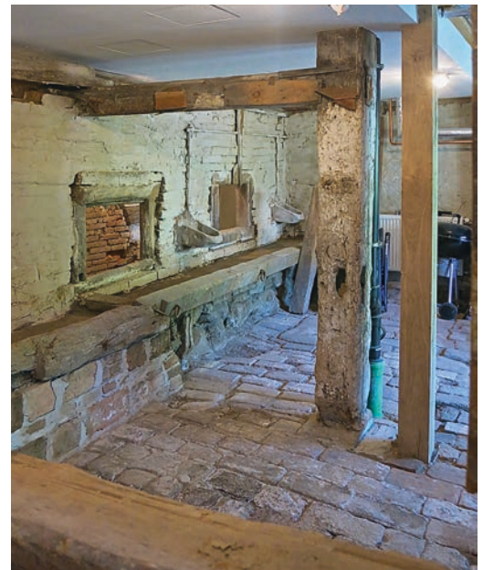
Der Stall im Erdgeschoss blieb in alter Form erhalten und dient heute als Raum für Fahrräder und Mülltonnen. (Foto: Gerhard Kabierske)
