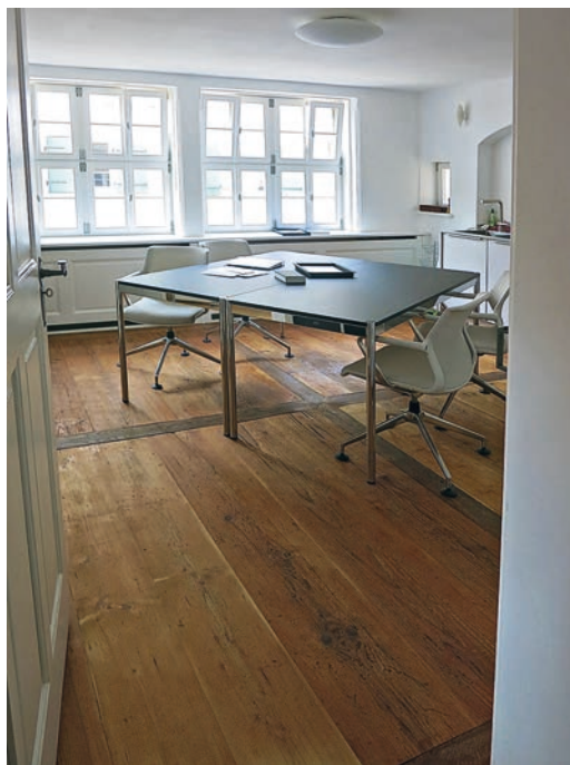
Ein repräsentatives Büro im ersten Obergeschoss. Der Dielenfußboden mit Friesteilung in Eiche wurde aufwändig restauriert. (Foto: Gerhard Kabierske)
