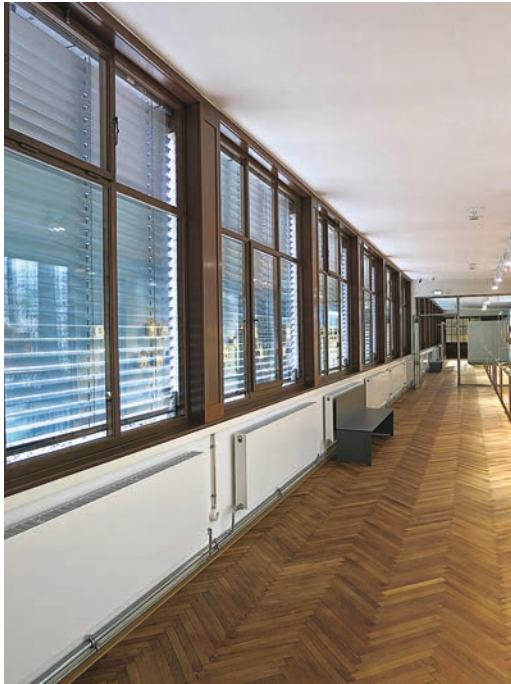
Die originalen Panzerfensterbänder mit fester doppelter Verglasung in den Arbeitsebenen wurden aufwändig saniert. (Foto: Gerhard Kabierske)
