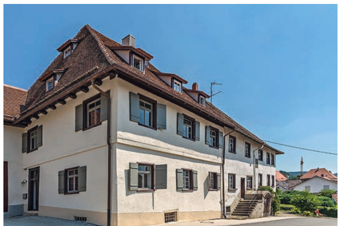
Das stattliche Rebleutehaus des Klosters Salem nahe beim Bodensee-ufer in Sipplingen. Die linke Haushälfte wurde vorbildlich saniert. (Foto: Ulrich Gräf)
