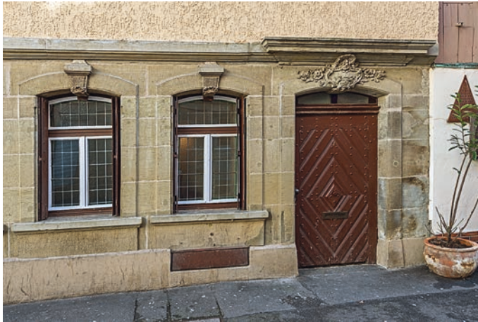
Das Erdgeschoss mit der original erhaltenen Haustüre, ein Beispiel für bürgerliche Baukultur des 18. Jahrhunderts in Stuttgart. (Foto: Iris Geiger-Messner LAD)
