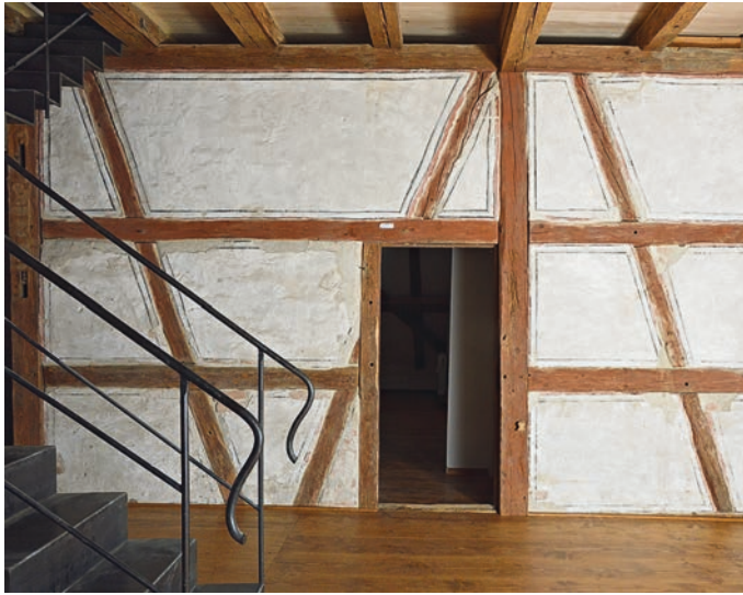
Der Anspruch der Reichsabtei Salem bei ihren Bauten lässt sich noch erkennen. Selbst Nebenräume im Dachgeschoss zeigen kunstvolle Beistriche an Fachwerkwänden. (Foto: Corinna Wagner-Sorg)
