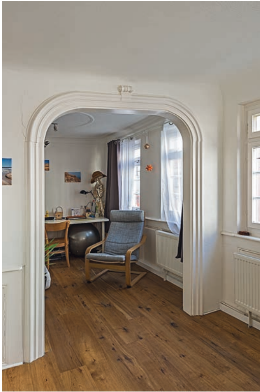
Aus der Erbauungszeit Mitte des 18. Jahrhunderts in einer Wohnung erhalten: Die korbogenförmige Rahmung eines Durchgangs. (Foto: Iris Geiger-Messner LAD)
