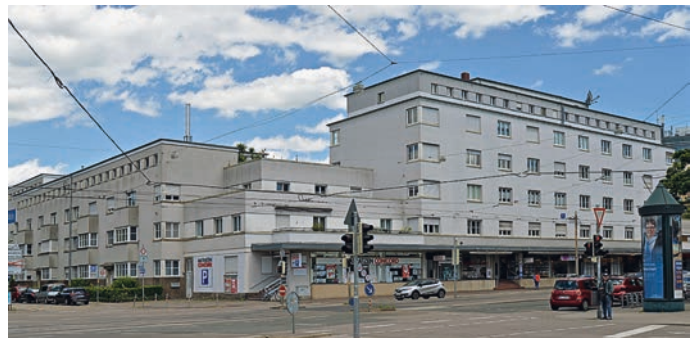
Der Wohnblock Ebertstraße von Hermann Alker ist einer der wichtigsten Beiträge zur Moderne der 1920er Jahre in Karlsruhe. Nach 1933 wandte sich der Architekt dem Nationalsozialismus zu.
