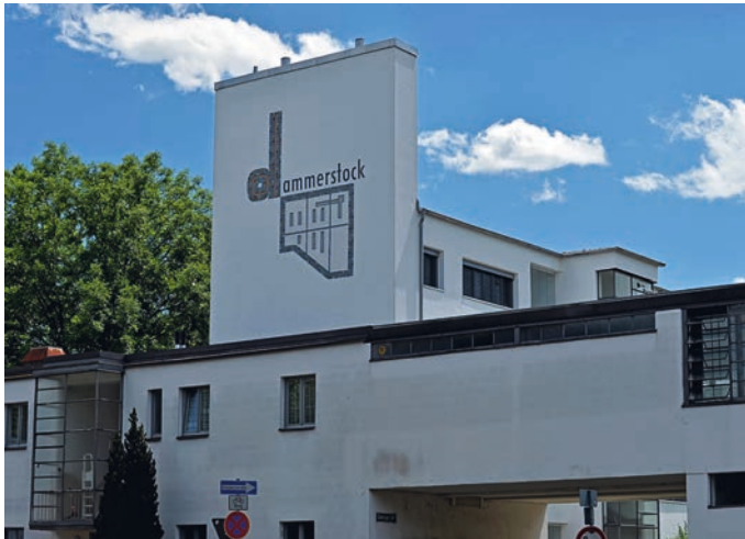
Der Kopfbau der Dammerstock-Siedlung mit Fernheizwerk und Zentralwaschgebäude wurde von Otto Haesler entworfen
