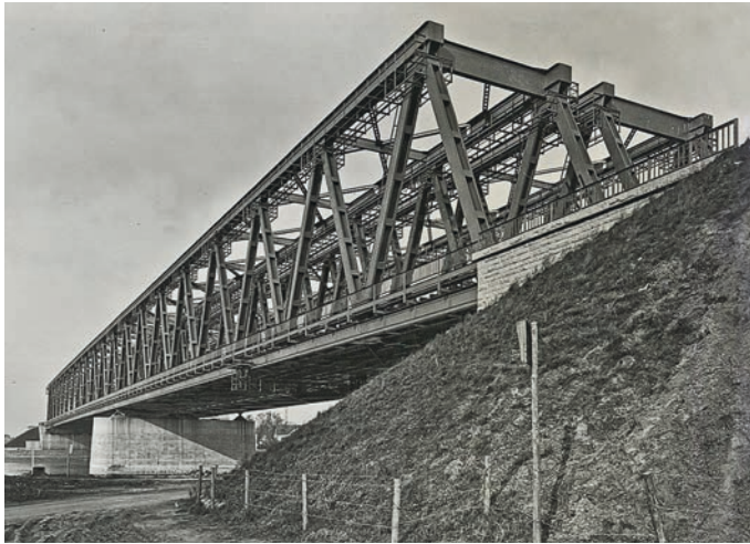
Maxau – Eisenbahnbrücke und Straßenbrücke, 1938 (GLA-KA_421Zug1993-90F-BrKa-2268)
