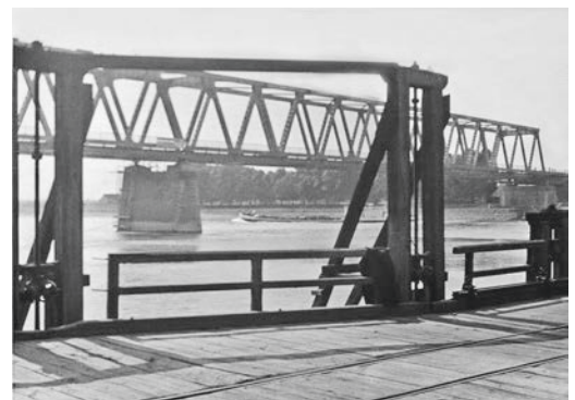
Speyer – Eisenbahn- und Straßenbrücke, 1938 (Foto 1937); davor Schiffsbrücke, 1873 (BAW_HB4915, _HB8950)
