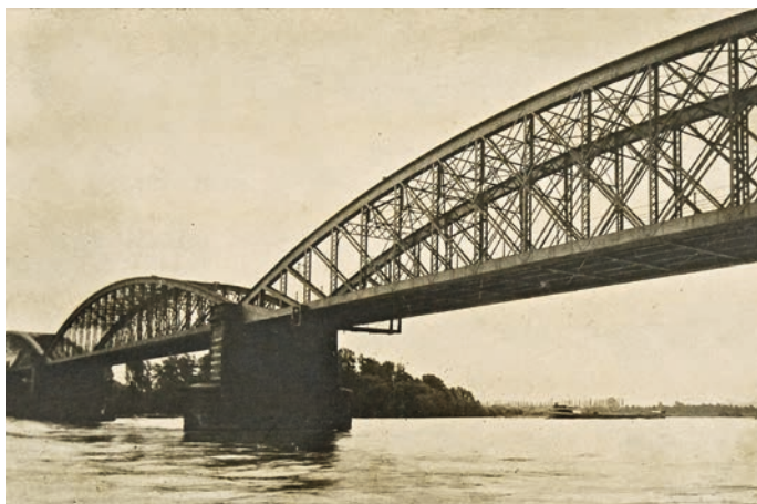
Germersheim – Eisenbahnbrücke, 1877 (BAW_HB8979)
