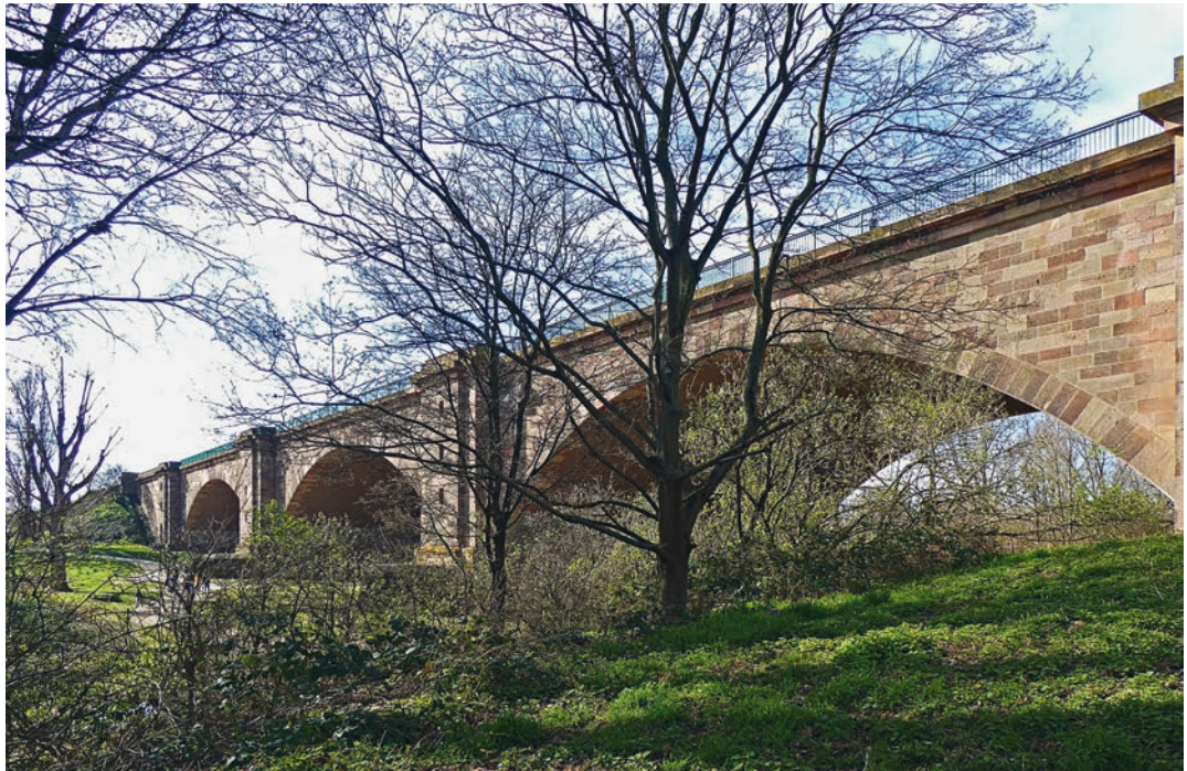
Mannheim – Straßenbrücke RAB 38, massive Bögen 1939; Stahlüberbau 1940 eingestürzt
