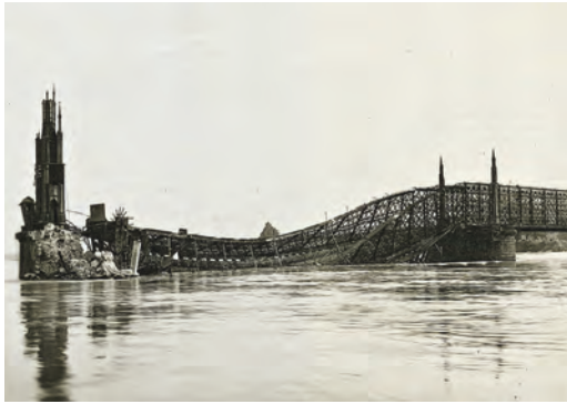
Strasbourg – Eisenbahnbrücke, nach der Sprengung 1940
