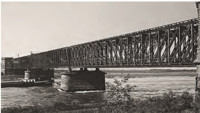
Weil – Eisenbahnbrücke, vor dem Abbau 1937
