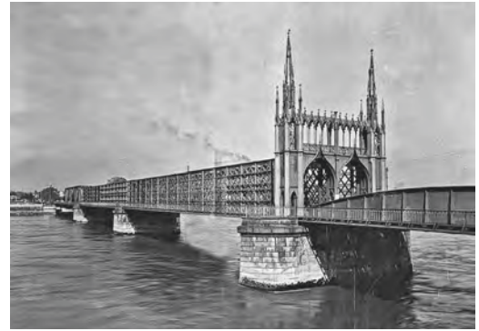
Strasbourg – Eisenbahnbrücke, Reparatur 1941
