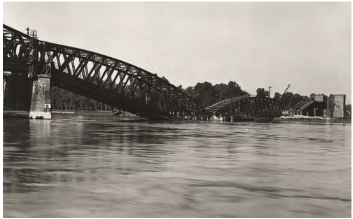
Wintersdorf – Eisenbahnbrücke, nach der Sprengung 1945
