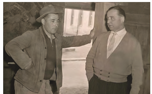
Bürgermeister Ernst Hug (rechts) zusammen mit Maurermeister Ernst Weiß im Jahr 1959 im Obergeschoß des Hebelhauses. (Bildvorlage: © Gemeinde Hausen im Wiesental)
