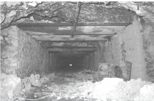
Abbildung 2. Oberer Hauptstollen (A), Innenansicht mit Ausbau. – Foto: Dr. C. KLIESCH.
