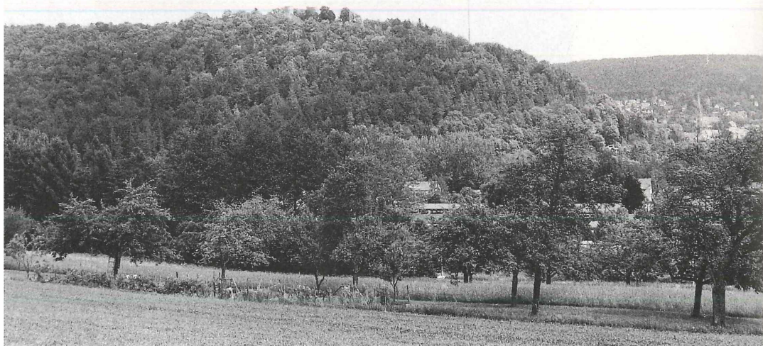
Blick auf den Nagolder Schloßberg; die Ruine ist kaum zu erkennen.
