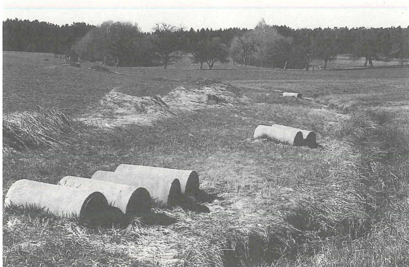
Nicht viel hätte gefehlt, und es wären Abschnitte der jungen Teinach in Rohre verlegt worden. Mit der Unterschutzstellung konnte das Vorhaben eines Privatmannes gerade noch gestoppt werden.
