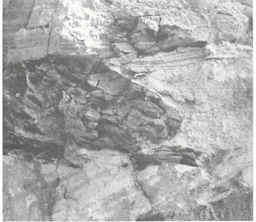
Abbildung 31. Steile Wände von Erosionsrinnen mit teilweise überhängenden Flanken infolge Unterspülung belegen eine beträchtliche Standfestigkeit der tonig-schluffigen Überschwemmungssedimente selbst bei Auskolkung bizarrer Reliefs an den Rändern der Wasserläufe. Mittlerer Buntsandstein, Oberfranken. Bildbreite etwa 30 cm. Sandgrube am Südwesthang der Tierleite an der Nordostseite des Trebgastales nordöstlich Sandreuth (Blatt 5935 Marktschorgast, r 69 840, h 42 560).
