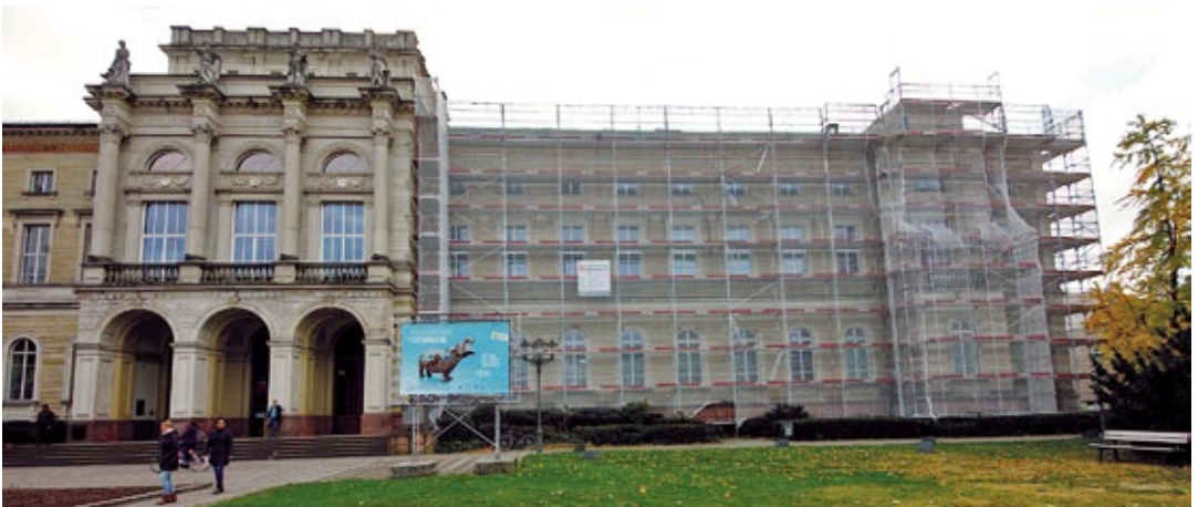
Abbildung 64. Die Sanierung des Gebäudes geht in die nächste Runde – nun ist das Dach dran...
