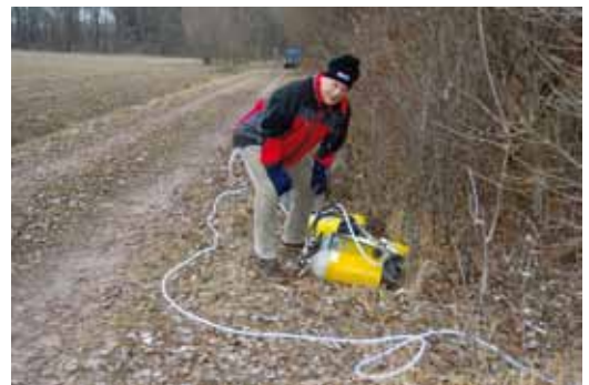
Abbildung 8. Die Ufertruppe sorgt dafür, dass für die Unterwasserarbeit immer ausreichend Druckluft zur Verfügung steht. – Foto: NORBERT LEIST.
