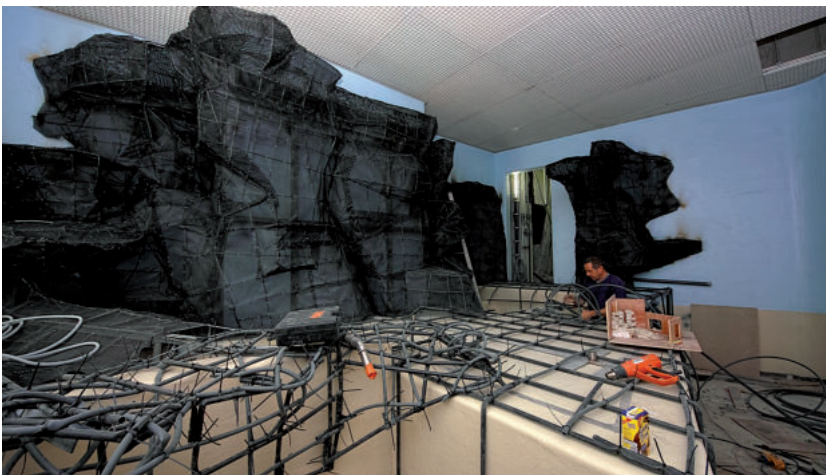
Abbildung 74. Mit Betonspritzpistole und handwerklichem Geschick entsteht ab Mai über der mit Gewebe verkleideten Stahl-Unterkonstruktion in der Krokodilanlage eine australische Sandsteinformation.
