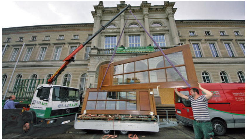
Abbildung 69. Nach der Restaurierung werden die Eingangstüren des Museums wieder angeliefert.
