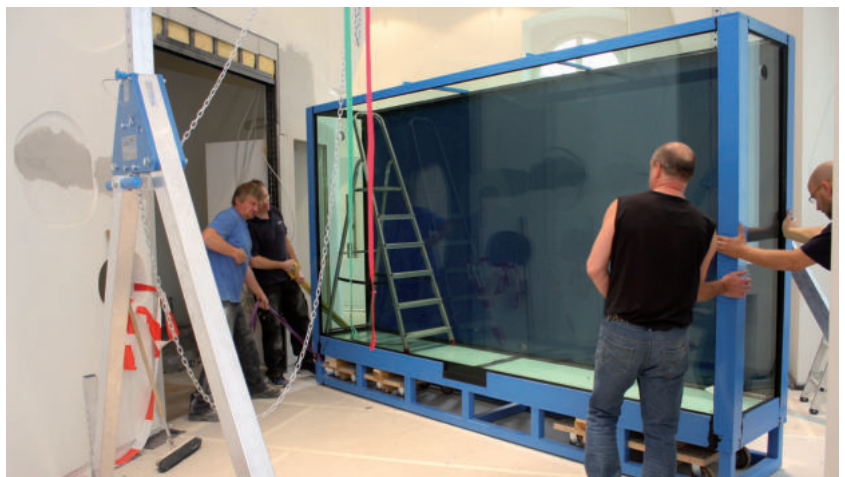
Abbildung 77. Auch ohne Wasserfüllung wiegt der neue Quallenkreisel rund 2.700 kg. Die exakte Positionierung hinter der Verkleidung wird daher zur logistischen Herausforderung.
