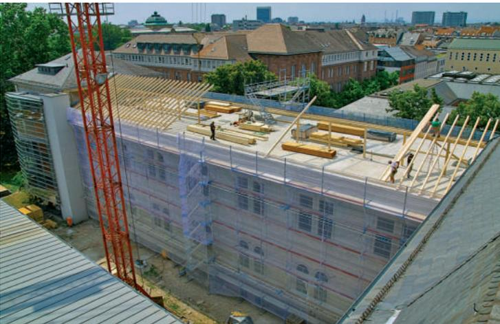
Abbildung 53. Nach Fertigstellung des Obergeschosses, in dem ein neuer Sonderausstellungsraum entsteht, wird im Juni 2014 der Dachstuhl errichtet.
