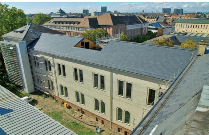
Abbildung 54. Im Oktober 2014 ist der Westflügel fast fertiggestellt. Im Dachgeschoss entsteht die neue Lüftungszentrale, die später mit einem Lamellendach verschlossen werden wird.
