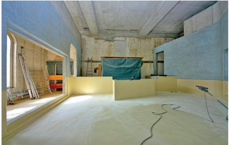
Abbildung 57. Große Schauaquarien erfordern eine umfangreiche Logistik, die im Untergeschoss des Westflügels untergebracht wurde. Zahlreiche Technikbecken aus Beton und ein kilometerlanges Leitungssystem für Süß- und Salzwasser sowie für die Heiz- und Kühlanlage sind im Oktober 2014 bereits realisiert.
