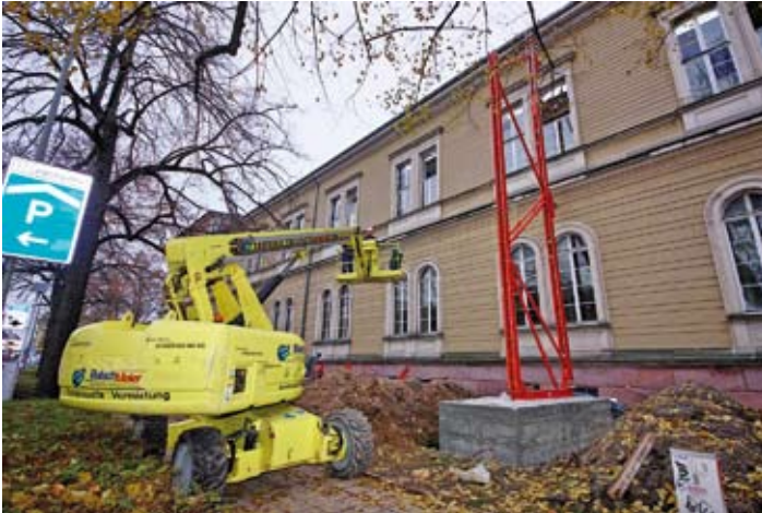
Abbildung 18. Um die Fassade des Westflügels während des Abrisses des gesamten dahinter liegenden Gebäudes erhalten zu können, muss sie mit schweren Gerüsten abgestützt werden. Sie stabilisieren die alte Bausubstanz bis zum Ende des Wiederaufbaus im Jahr 2014.
