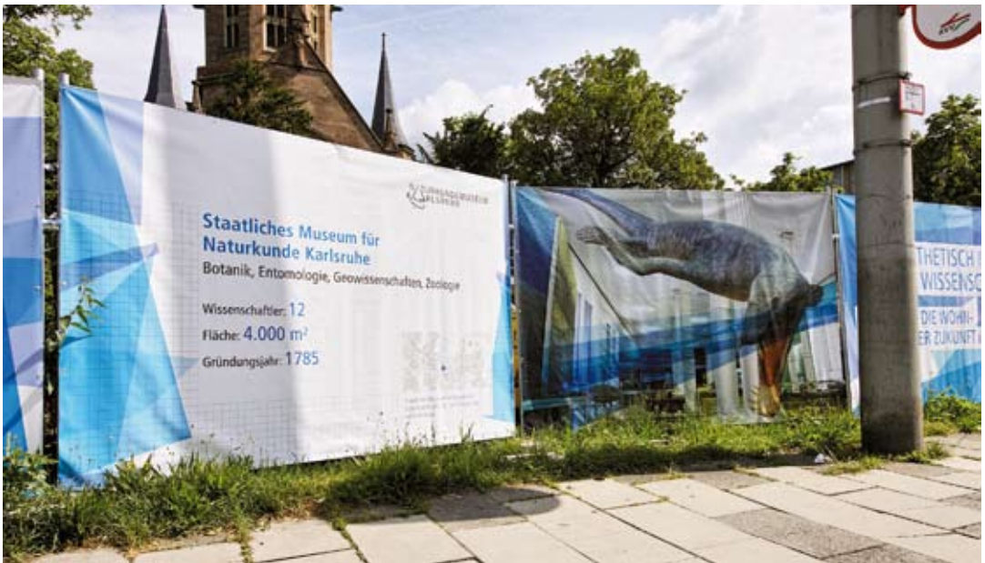
Abbildung 14. Die zahlreichen Bauzäune in Karlsruhe bieten viel Fläche für Werbemaßnahmen, die vom Marketing des Hauses klug genutzt wurden. Hier im Bild der Bauzaun der U-Bahn-Baustelle am Mühlburger Tor, im Hintergrund die Christuskirche.
