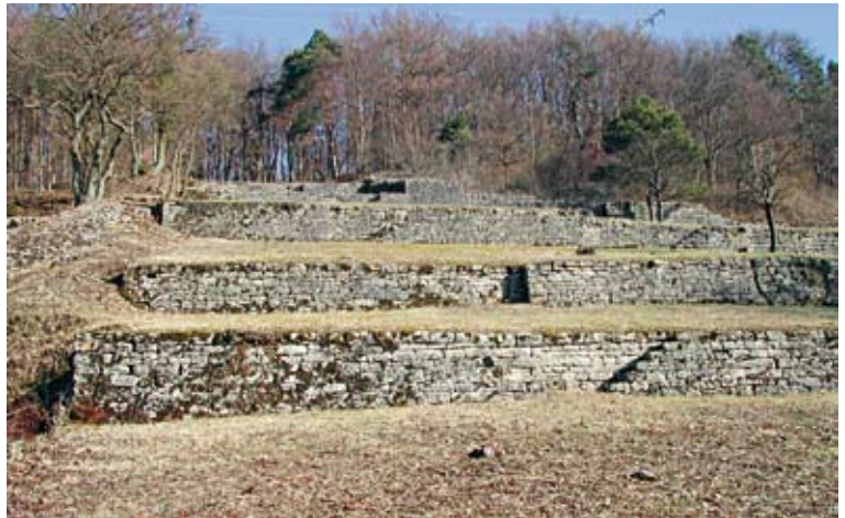
b) Trockenmauern nach der Freistellung im Jahr 2009. – Foto: B. BRUNNER.
