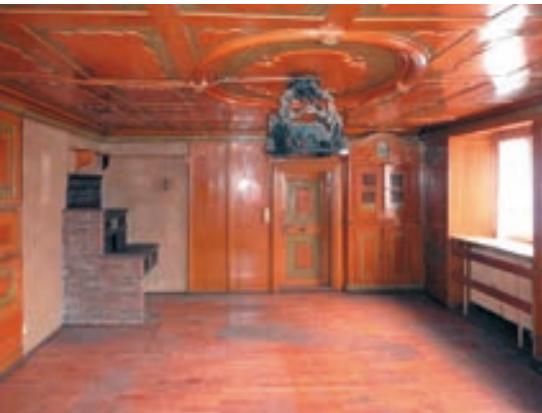
Abb. 9: Amtsstube Erdgeschoss, noch nicht saniert. Foto 2020 Ralf Kornhaas.
