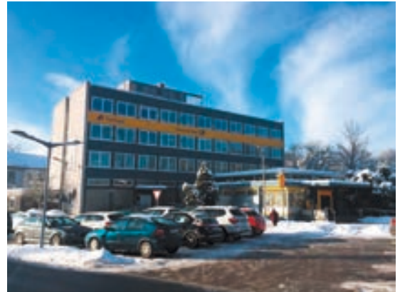
Abb. 5: Postgebäude von Norden, mit vorgelagerter eingeschossiger Schalterhalle.
