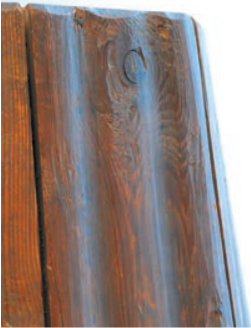
Abb. 4: Daubenstellung und Wellung der Tonne des „Spanischen Mantels“ aus Villingen. Foto: Verfasser.
