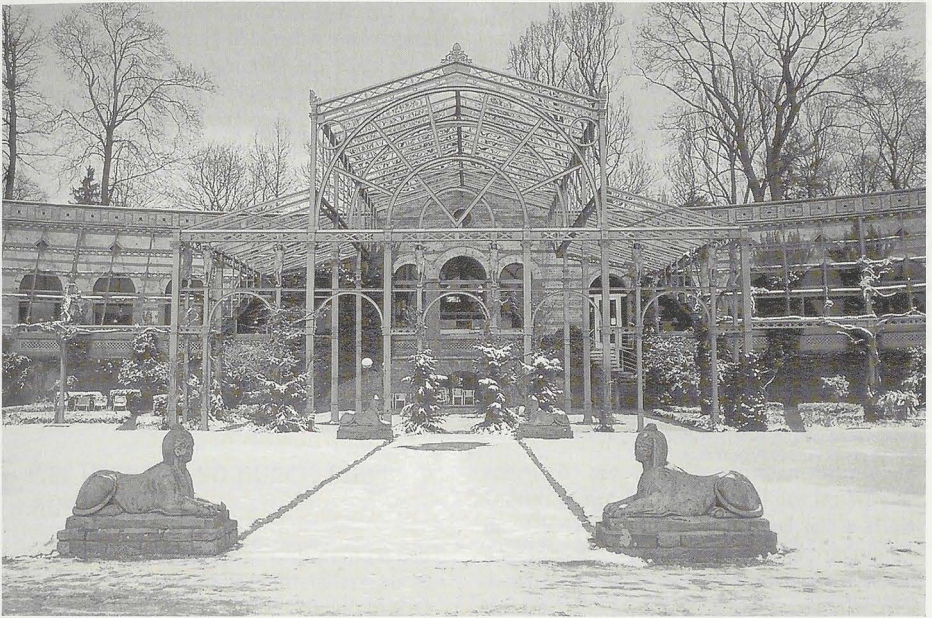
Gartenansicht mit dem nach dem Zweiten Weltkrieg als Gerüst wieder errichteten Wintergarten
