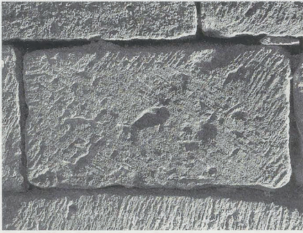
Der dreiseitige Randschlag zeigt, dass der Quader ursprünglich ein anderes Format hatte und erst nachträglich in diese Form gebracht wurde
