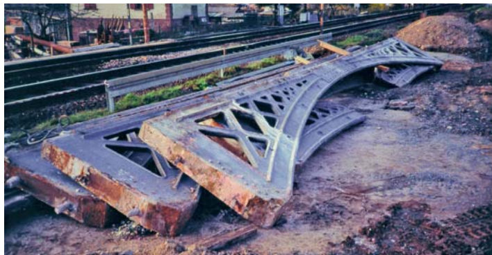
Abb. 8: Abgebaute Randträger bei Ettlingen, 1992_ Boeyng
