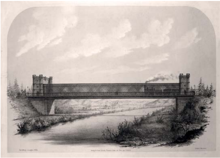
Abb. 10: Eiserne Gitterbrücke über die Kinzig bei Offenburg, Lithographie, 1853_StA-OG_26-1-280
