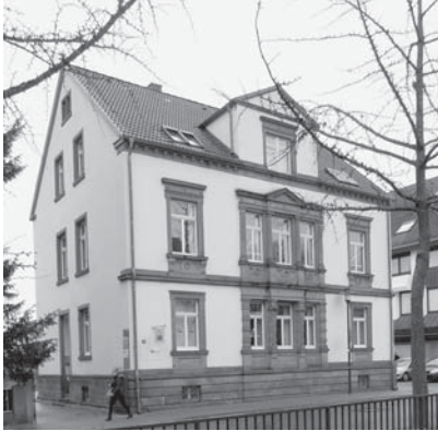
Abb. 16: Villa Mittenmaier (Eisenbahnstraße 24). Foto: Coenen
