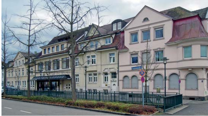
Abb. 31: Die Reihenbebauung Eisenbahnstraße 31, 33, 35 und 37 entstand im späten 19. und frühen 20. Jahrhundert. Foto: Coenen
