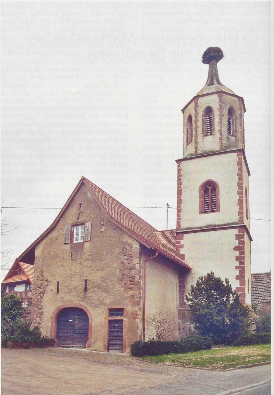
Abb. 1: Denzlingen, die ehemalige Michaelskirche von Südwesten mit dem neuen Dach Zeichnungen und Aufnahmen vom Verfasser
