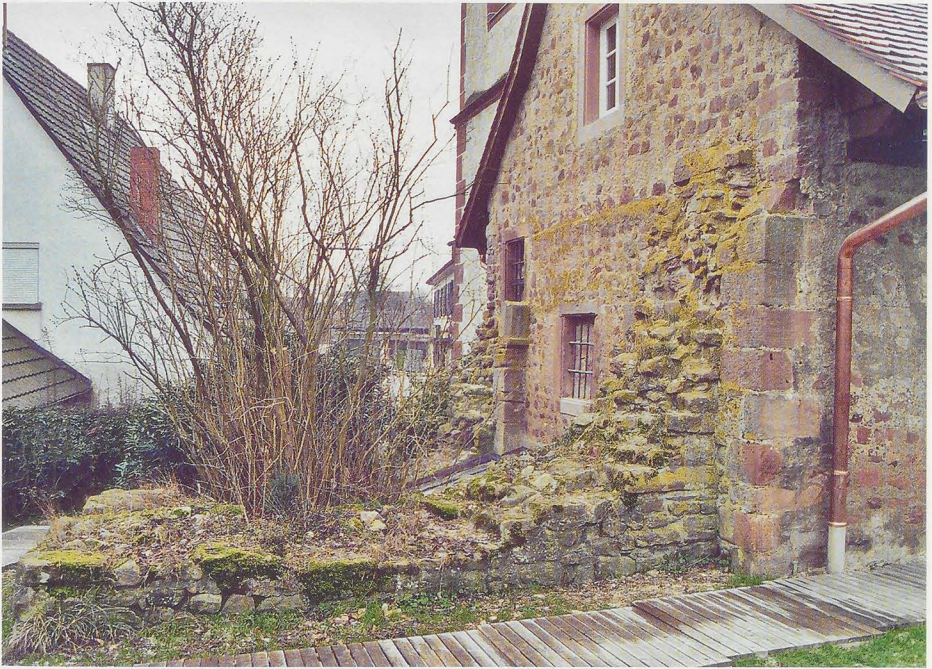
Abb. 2: Denzlingen, ehem. Michaelskirche, freipräparierte Fundamente und Maueranschlüsse des einstigen Chorraums; hinten erkennbar eine der beiden Leibungen der Choröffnung mit Kämpfer und Bogenansatz
