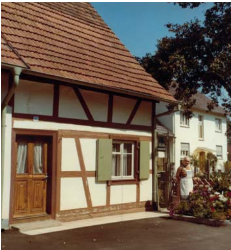
Elternhaus, bereits abgerissen
