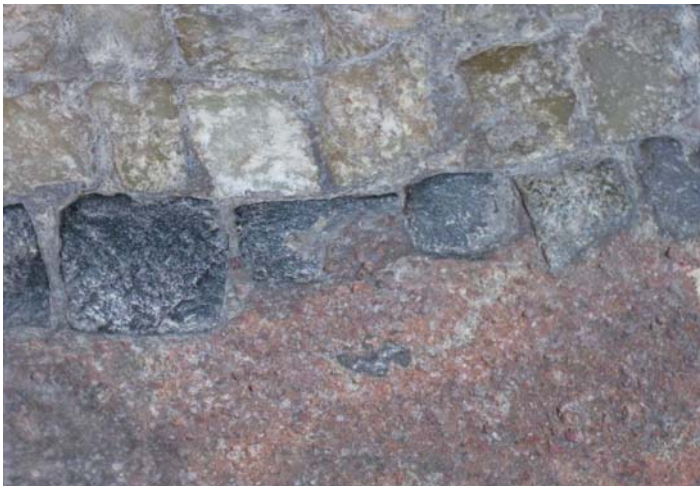
Abb. 8: Steinchen im Randbereich, die von dem rötlichen Mörtel der Einfassung überdeckt werden.
