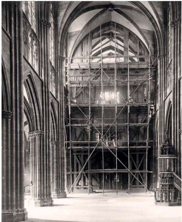
Abb. 9: Bauzaun zwischen dem Langhaus und der Pfeilerbaustelle, 1912
