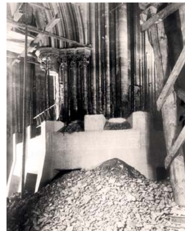
Abb. 14 (unten): Stahlbetonkorsett und Schutthalde
