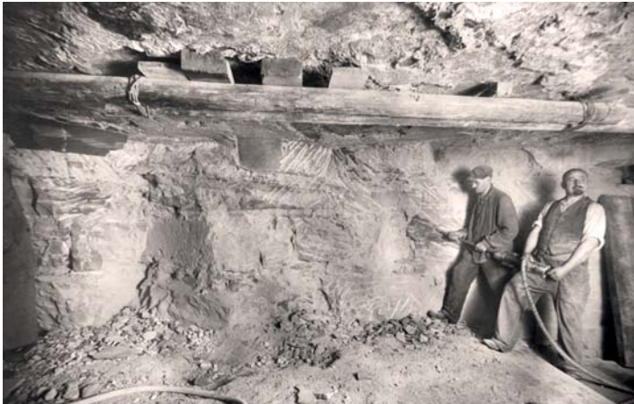
Abb. 12 (links): Arbeiter tragen die mittelalterlichen Fundamente unter dem Turmpfeiler ab
