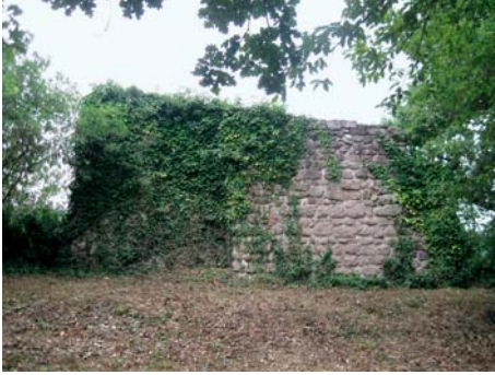
Abb. 1: Innenansicht eines Teilstücks der südwestlichen Längswand der Kernburg (mit Kaminzug?; 8.9.2013).
