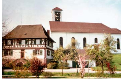
Abb. 18 b: Pfarrhaus und Kirche nach der Erweiterung der Kirche 1964–1968 (Aufnahme von 1979)
