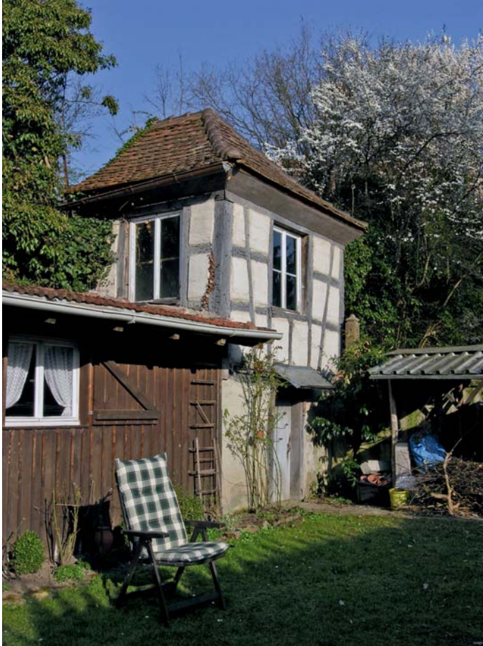
Abb. 1: Zweistöckiges Gartenhäuschen im Finsterwäldle
