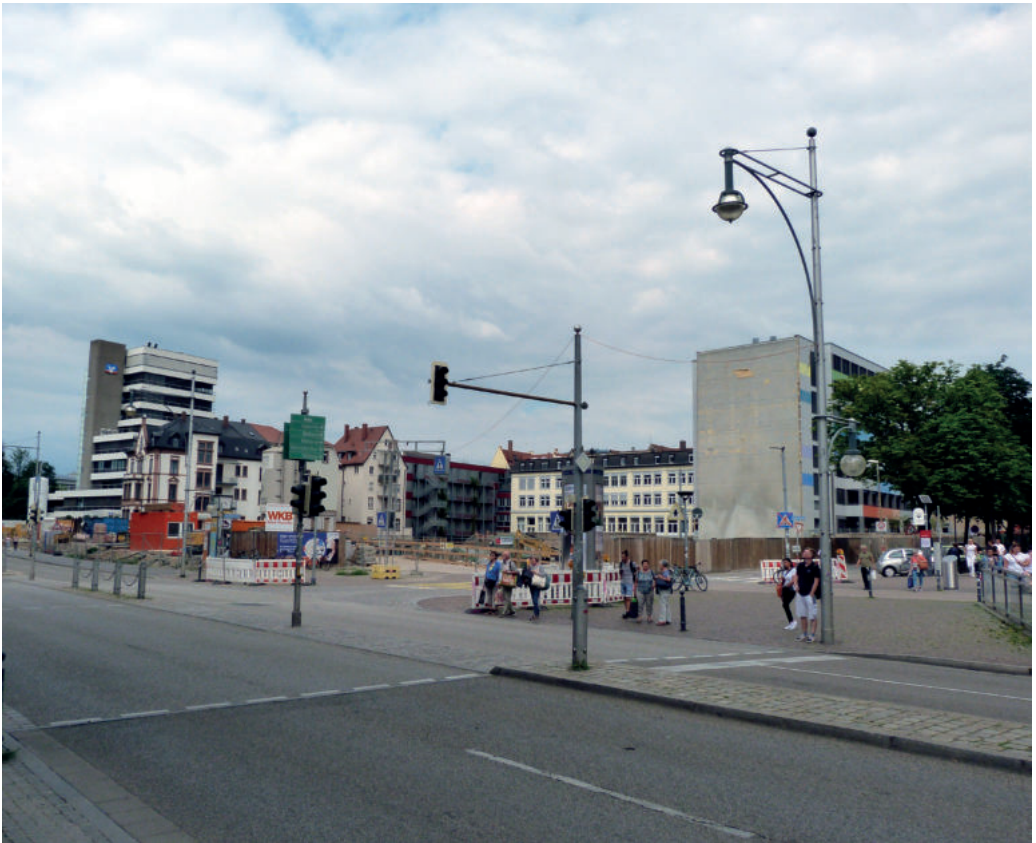
Abb. 29: 2018 Volksbankgelände nach dem Abriss. Foto: Sven Koppler.
