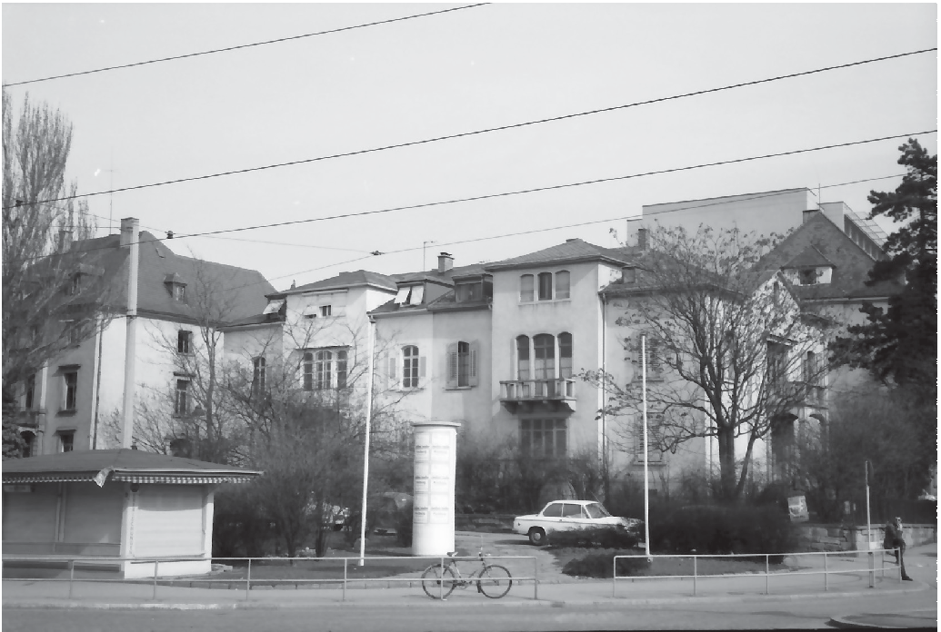
Abb. 25: 1971 Eckhaus Eisenbahnstraße 49 und Bahnhofstraße 10 bis 12. Quelle: Landesarchiv Baden-Württemberg, Staatsarchiv Freiburg, W 134 Nr. 094111a Bild 1, Fotograf: Willy Pragher.
