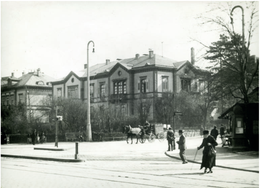
Abb. 24: um 1930: Eisenbahnstraße 49 und (damals) Bahnhofstraße 10–12. Vorlage: Stadtarchiv Freiburg, Sign.: M 7010 Bismarckallee, Fotograf: unbekannt.
