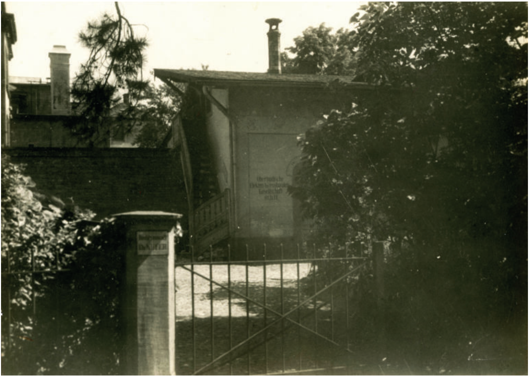
Abb. 26: Seitenbau Nr. 49 um 1930. Vorlage: Stadtarchiv Freiburg, Sign.: M 705 201/27 Nr. 136.
