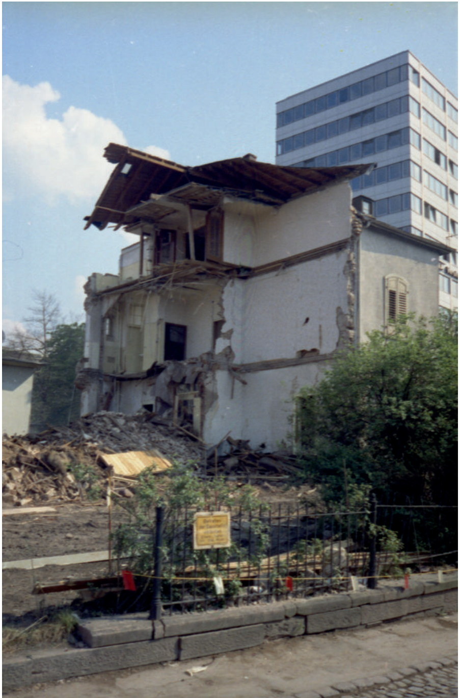
Abb. 27: 1971 Abriss Eisenbahnstraße 49. Quelle: Landesarchiv Baden-Württemberg, Staatsarchiv Freiburg, W 134 Nr. 094130e Bild 1, Fotograf: Willy Pragher.
