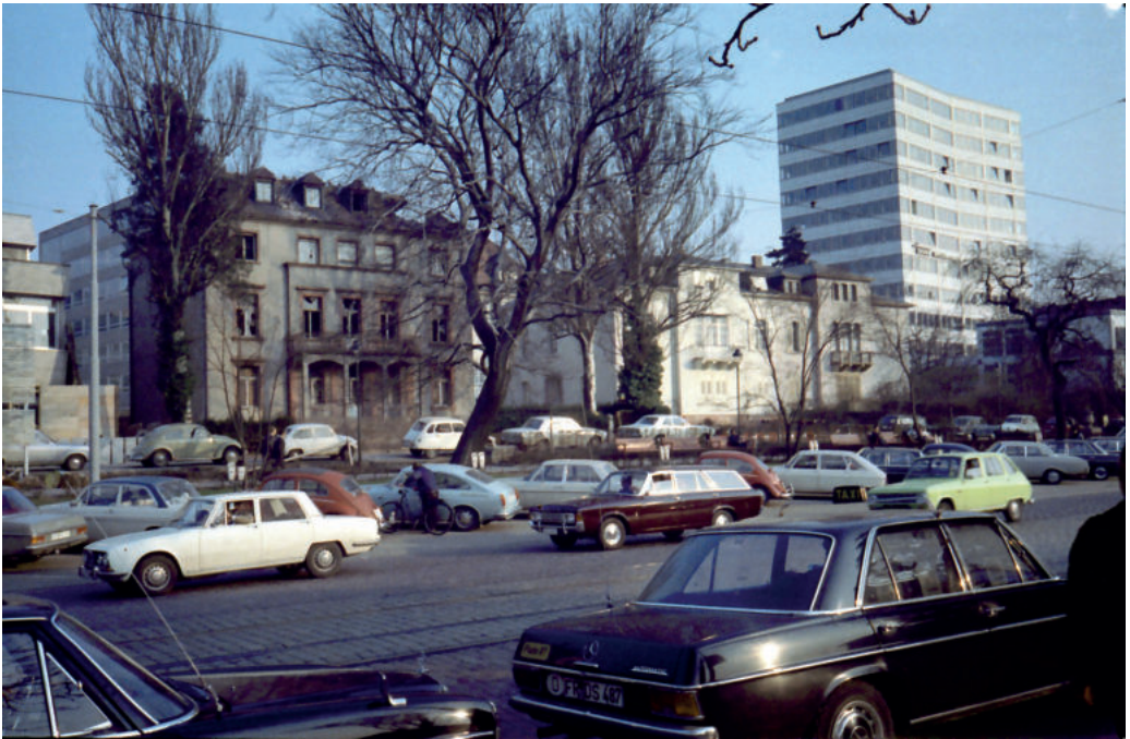
Abb. 37: 1971 Eisenbahnstraße 49 und Bismarckallee 10–12 vor dem Abriss für den Volksbank-Neubau, Nr. 14 im Bild links angeschnitten. Quelle: Landesarchiv Baden-Württemberg, Staatsarchiv Freiburg, W 134 Nr. 094116d Bild 1, Fotograf: Willy Pragher.
