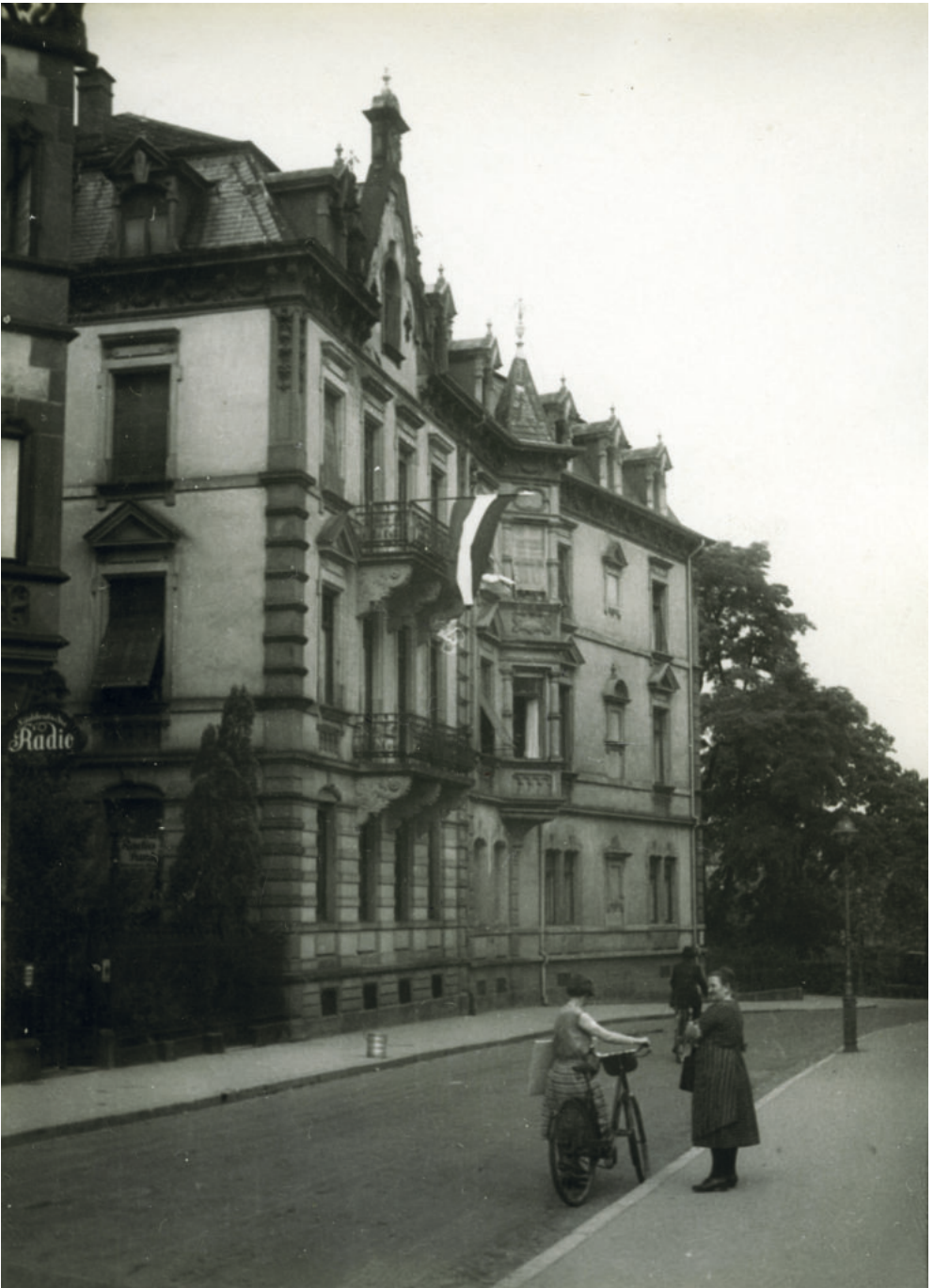
Abb. 33: Rosastraße 16 in den späten 1920er Jahren. Vorlage: Stadtarchiv Freiburg, Sign.: M 70S 201/27 Nr. 221.
