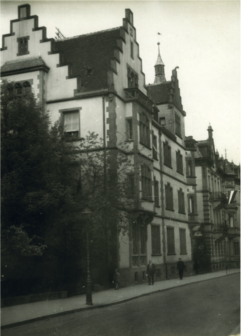
Abb. 32: Rosastraße 12 und 14 in den späten 1920er Jahren. Vorlage: Stadtarchiv Freiburg, Sign.: M 70S 201/27 Nr. 220.
