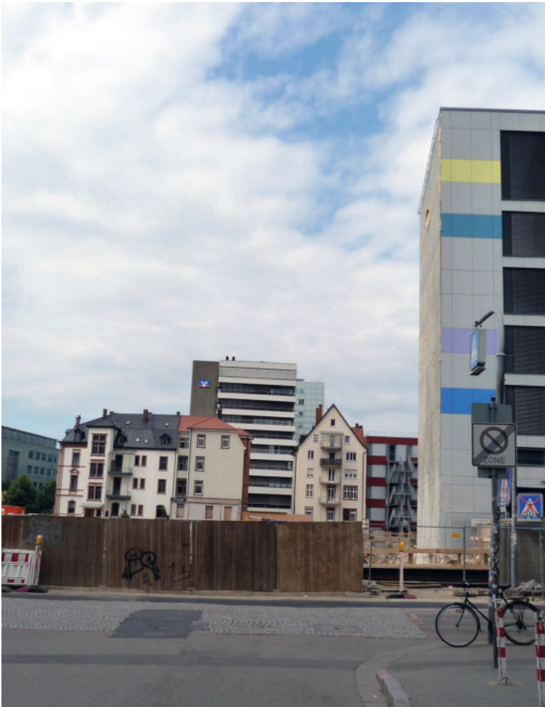
Abb. 23: 2018 Rheingold- und Volksbankgelände nach dem Abriss. Foto: Sven Koppler.
