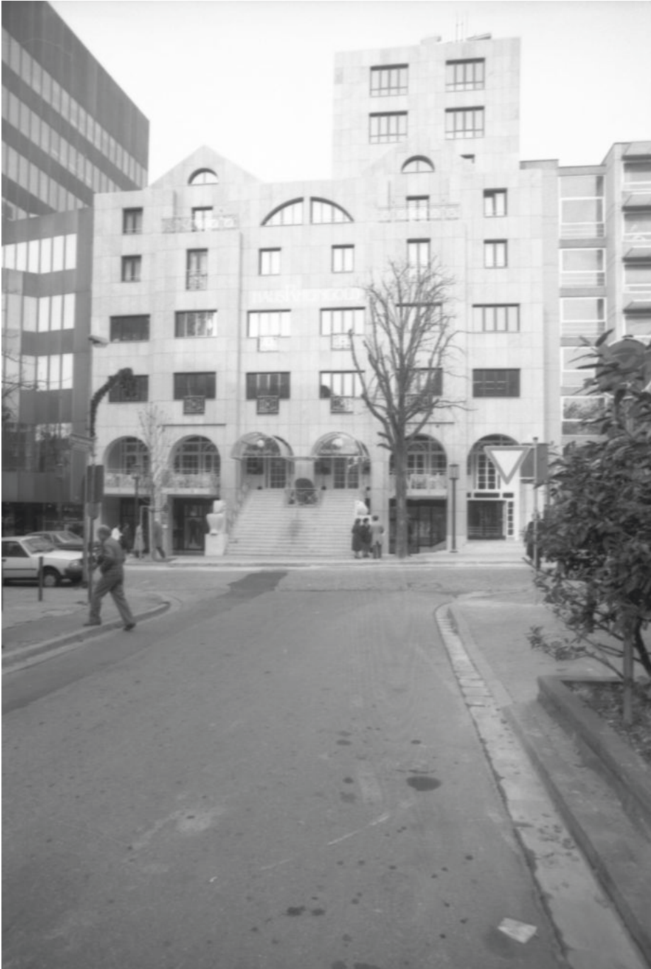
Abb. 22: 1985 Das neue Rheingold mit Freitreppe. Quelle: Landesarchiv Baden-Württemberg, Staatsarchiv Freiburg, W 134 Nr. 121214c Bild 1, Fotograf: Willy Pragher.
