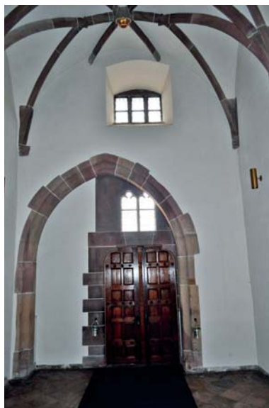
Abb. 11: Der vermauerte, von innen noch sichtbare gotische Chorbogen sieht nach links verrückt aus. Diese asymmetrische Bauweise im Innern war nötig, um Symmetrie außen zu erreichen.
