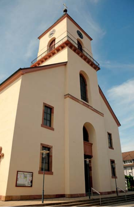
Abb. 17: (links) Die katholische Heilig-Kreuz-Kirche in Renchen versteckt ihren Portalchor hinter einer modernen Haut
